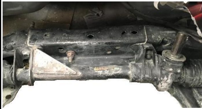
Refuerzo caja dirección
